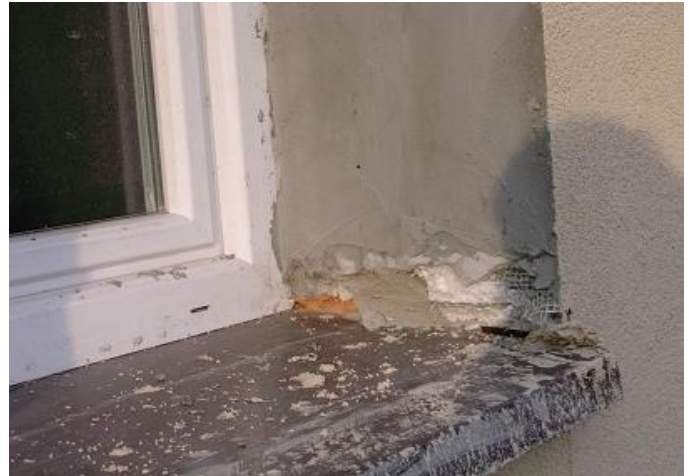
Nieprofesjonalne wykonanie ościeża, brak możliwości nałożenia tynku
