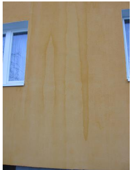
Zalanie tynku mineralnego przed malowaniem farbą elewacyjną, drastyczne pogorszenie wyglądu elewacji, widoczne zacieki
