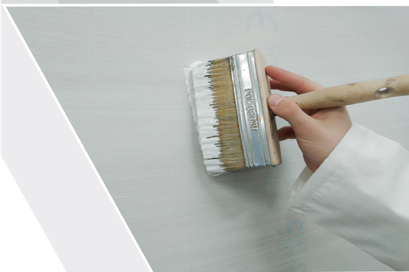
Gruntowanie podłoża
