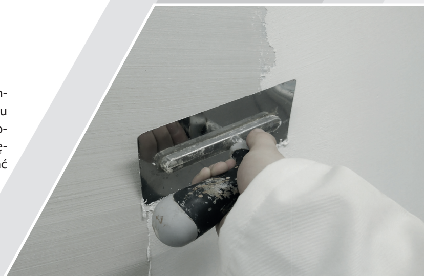
Nakładanie pierwszej warstwy masy dekoracyjnej
